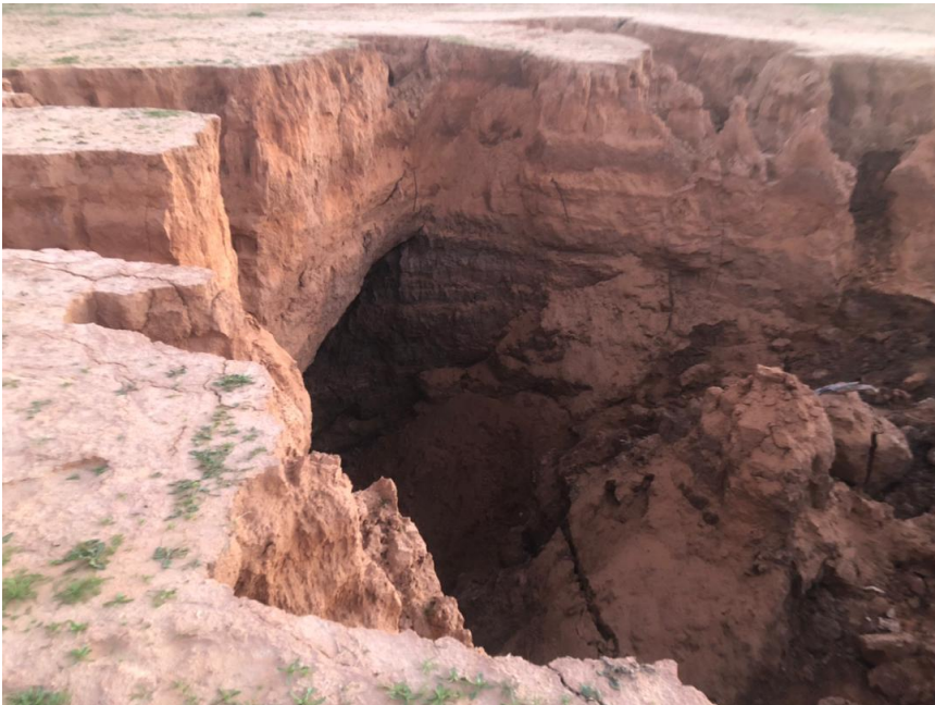
شكل 7: انهيار أرضي في منطقة أولاد أبو عائشة (الهيبة) المصدر : صورة للمؤلف
