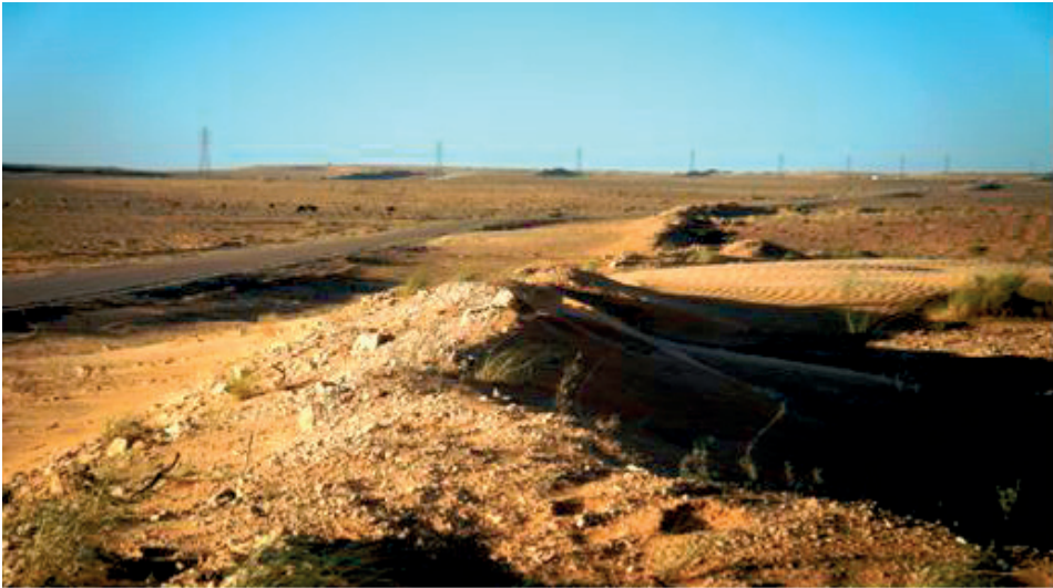
شكل (7) السدود الترابية المستخدمة لوقف زحف الرمال على طريق ( نالوت/غدامس )
