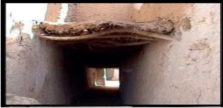
شكل (12): تبين استعمال أشجار الأثل في التسقيف(3)
