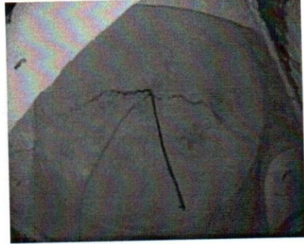
شكل 2. مسجد المشاط، مراقبة التشققات (صورة بواسطة المؤلف)
