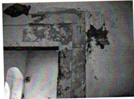
شكل 10. القنصلية الانجليزية سابقا، الرطوبة بالحوائط (صورة بواسطة المؤلف)
