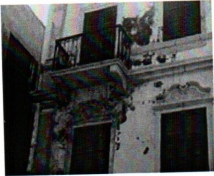
شكل 11. مصرف روما سابقا، رطوبة عالية بالحوائط (صورة بواسطة المؤلف)
