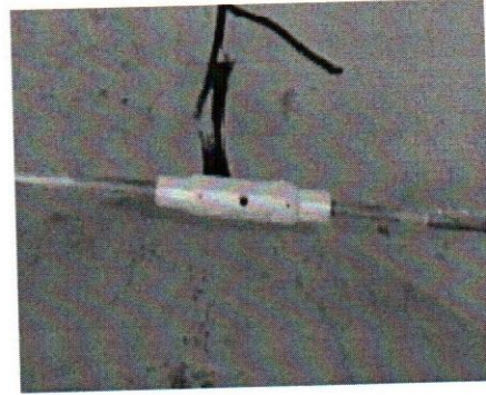
شكل 7. المتحف الإسلامي، روابط معدنية سابقة الاجهاد استعملت لدعم الأقواس (صورة بواسطة المؤلف)
