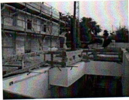
شكل 20. المتحف الاسلامي، خدمات تحت ارضية تم تأسيسها بجوار المبنى التاريخي لتوفير انظمة التزود
