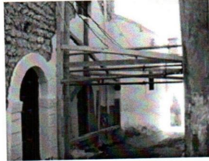
شكل 1. مسجد المشاط، دعم الحوائط المتشققة أثناء أعمال الترميم (صورة بواسطة المؤلف)
