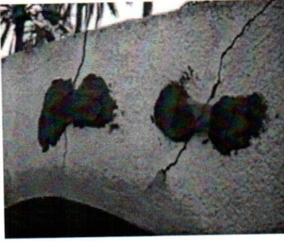
شكل 3. المتحف الاسلامي، مراقبة تمدد التشققات (صورة بواسطة المؤلف)
