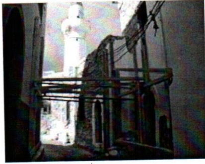
شكل 1. مسجد المشاط، دعم الحوائط المتشققة أثناء أعمال الترميم (صورة بواسطة المؤلف)
