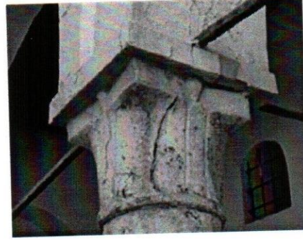
شكل 6. القنصلية الانجليزية سابقاً، روابط معدنية غير ملائمة استعملت لدعم الأقواس (صورة بواسطة المؤلف)
