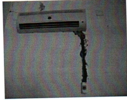
شكل 19. القنصلية الفرنسية سابقا، تم توصيل خيوط الكهرباء عشوائيا في الحوائط الحوائط (صورة بواسطة
