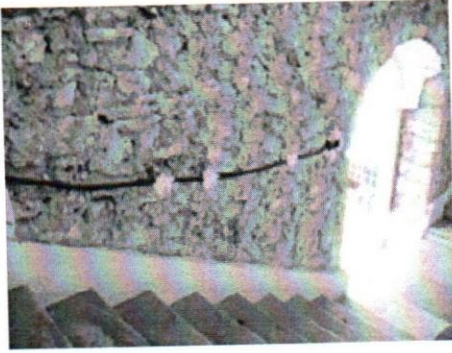
شكل 19. القنصلية الفرنسية سابقا، تم توصيل خيوط الكهرباء عشوائيا في الحوائط الحوائط (صورة بواسطة
