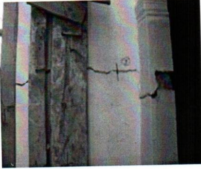
شكل 2. مسجد المشاط، مراقبة التشققات (صورة بواسطة المؤلف)
