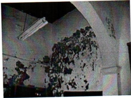
شكل 10. القنصلية الانجليزية سابقا، الرطوبة بالحوائط (صورة بواسطة المؤلف)
